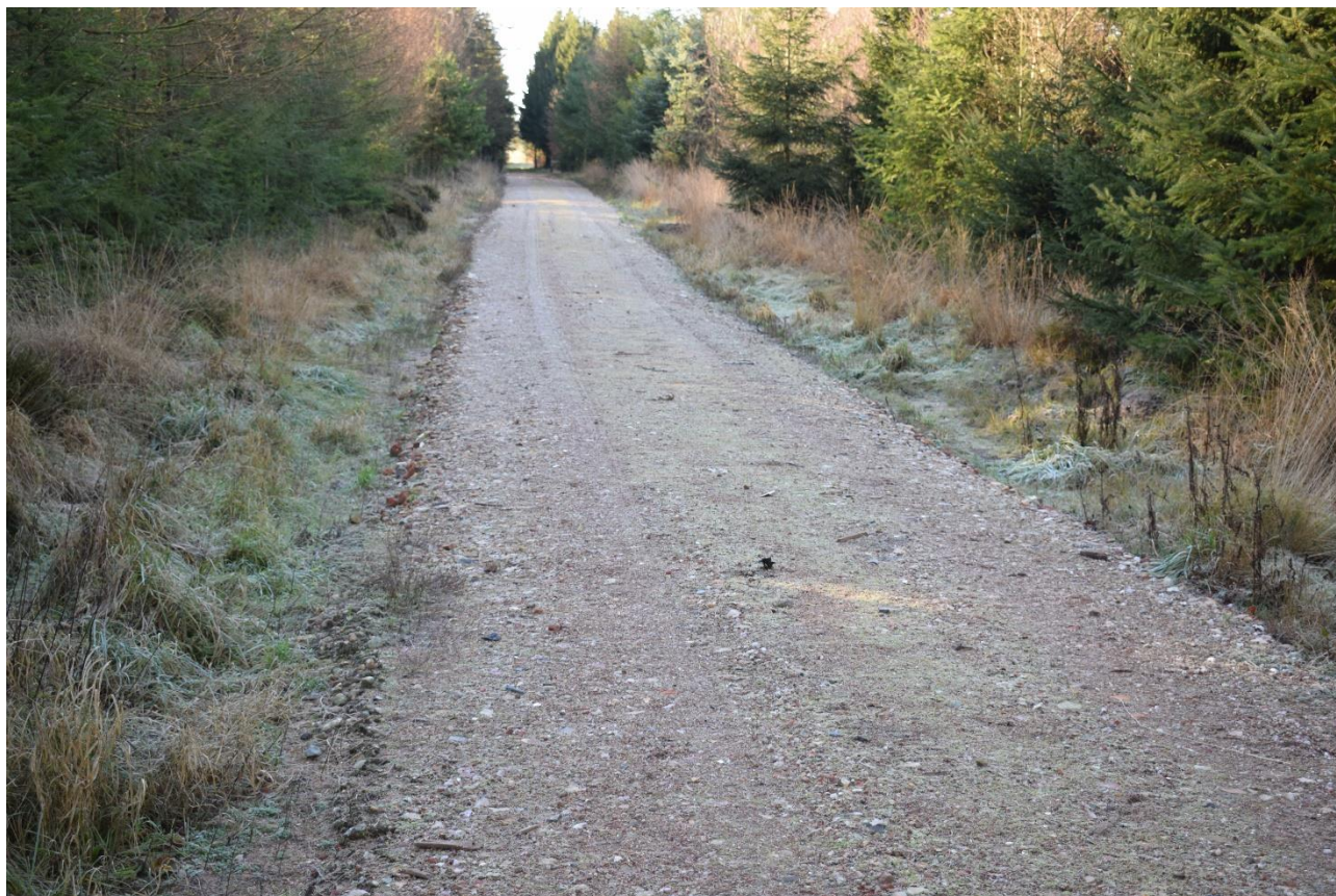
Figur 6: Bestyrelsen lægger vægt på, at plantagernes infrastruktur, f.eks. grøfter og veje, kontinuerligt vedligeholdes. Vej-standarden er vigtig at opretholde. Her et eksempel på, hvordan en renovering ser ud. Læg mærke til, at regnvandet ledes bort i kanterne. Foto 2. december 2016.
